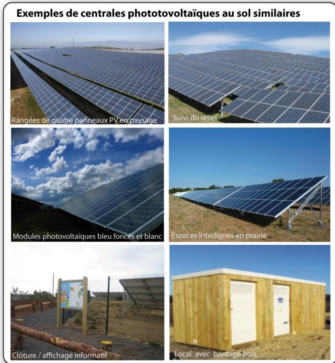
Photographie 56 : Exemples de centrales photovoltaïques au sol.
